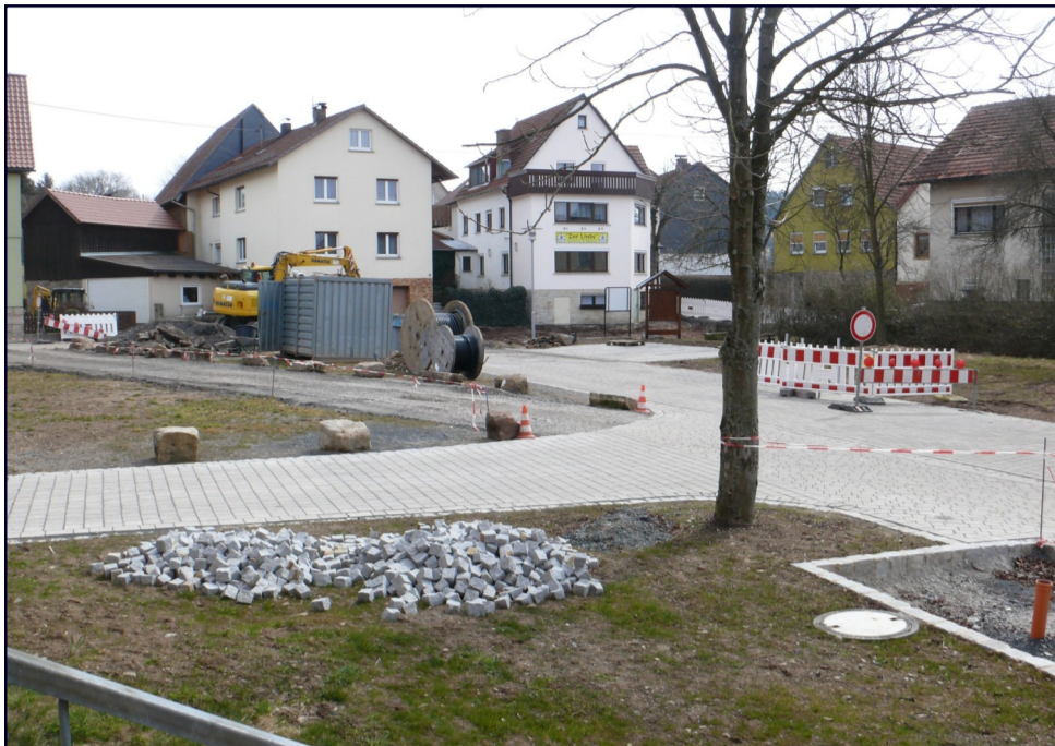
Während nach Abschluss von zwei Teilbaumaßnahmen in Friesen im oberen Dorf die 3. Baumaßnahme zur Dorferneuerung in vollem Gange ist ...
